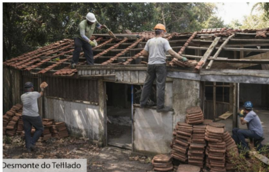
Desmonte do Telhado
